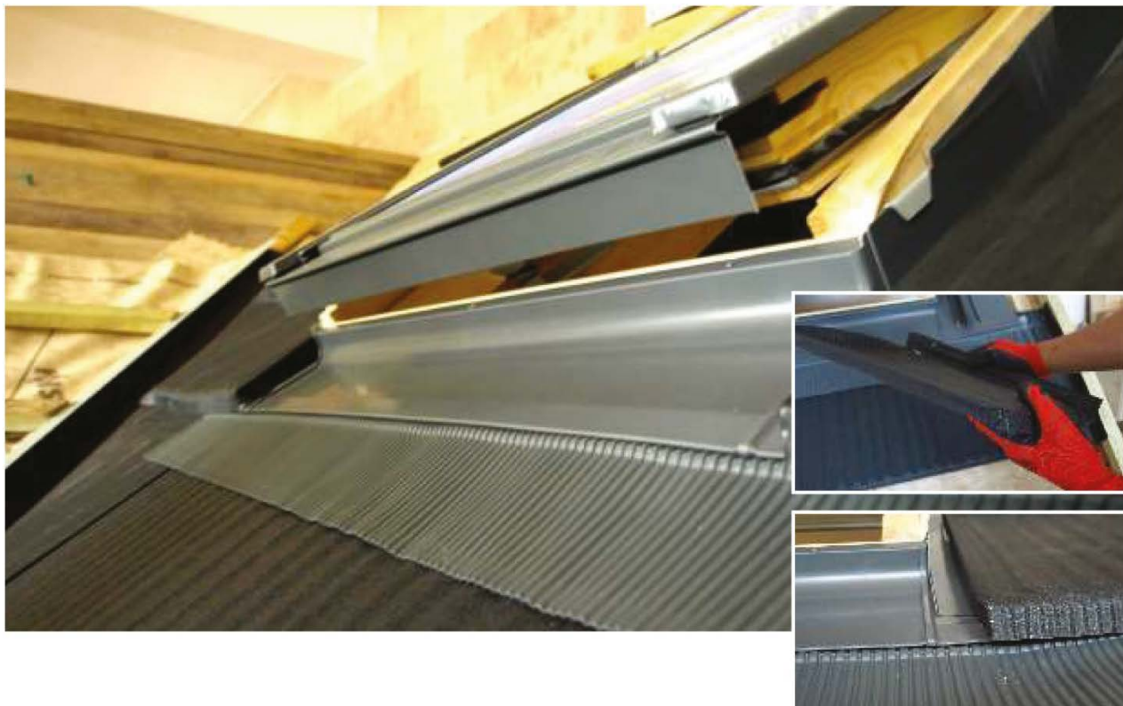
Вигляд змонтованого мансардного вікна
