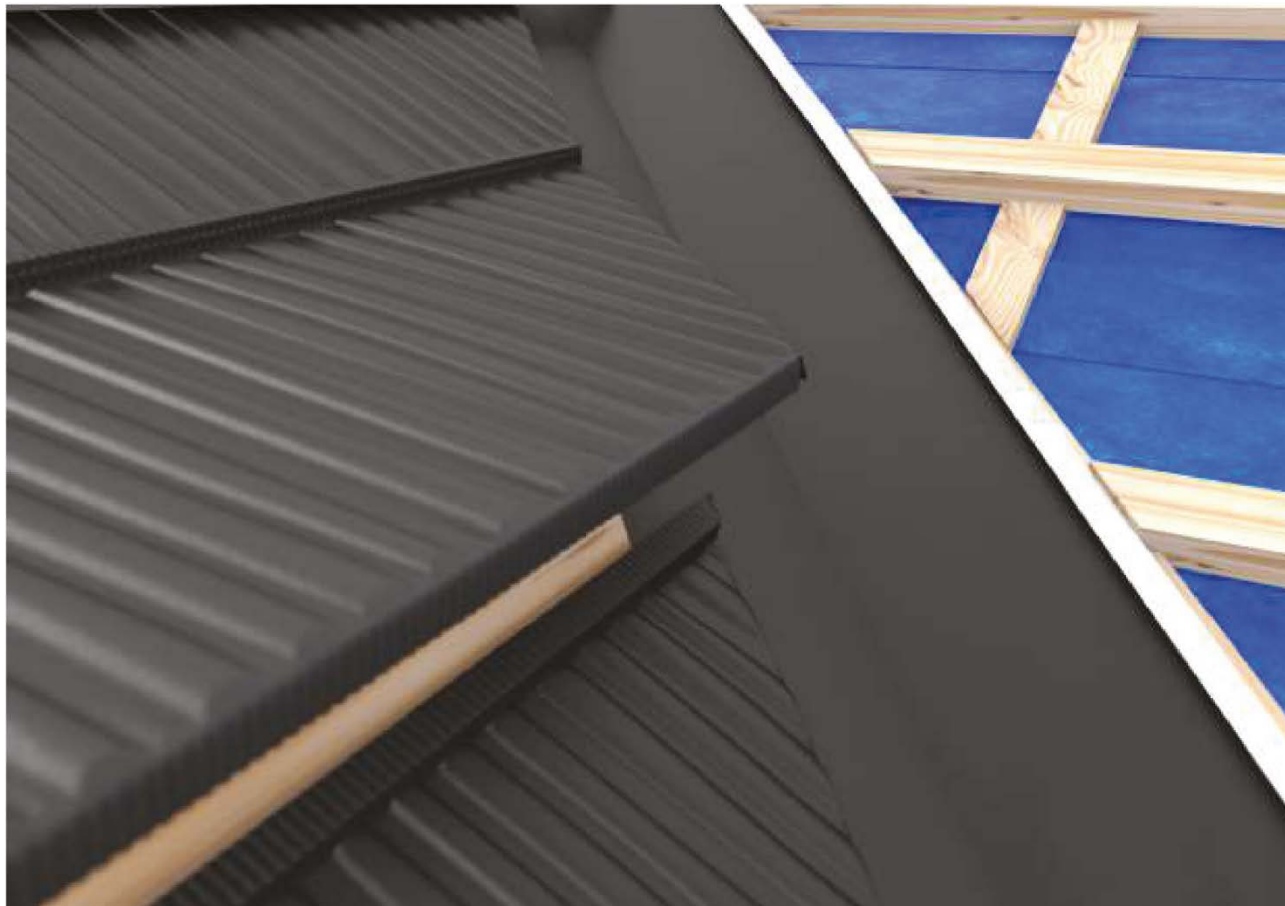
Монтаж модулів металочерепиці до кошикової ринви
